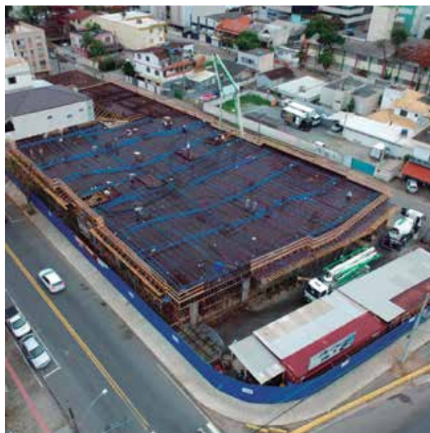
Obra em Santa Catarina com o sistema de laje protendida
