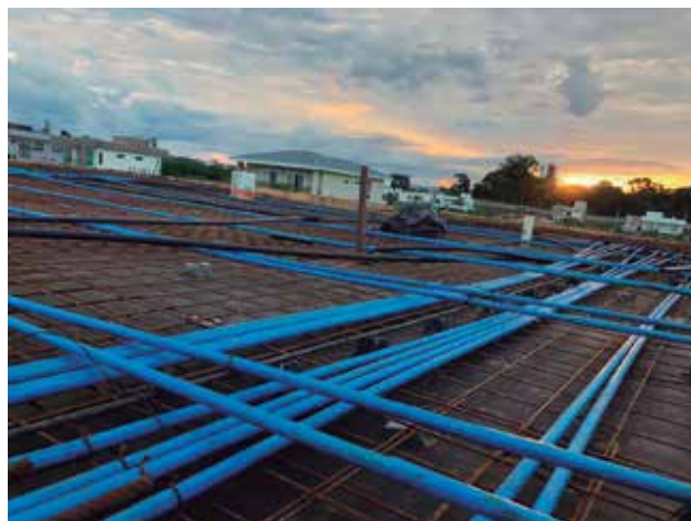
Distribuição das cordoalhas no assoalho da forma da laje
