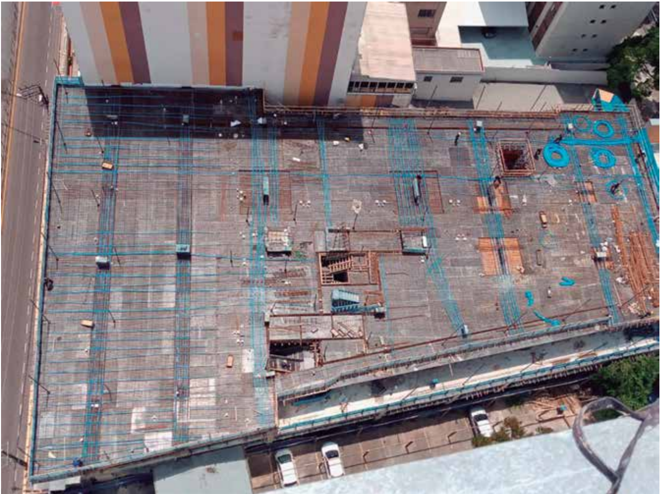
Construção de prédio com 25 pavimentos utilizando o sistema de lajes lisas protendidas
