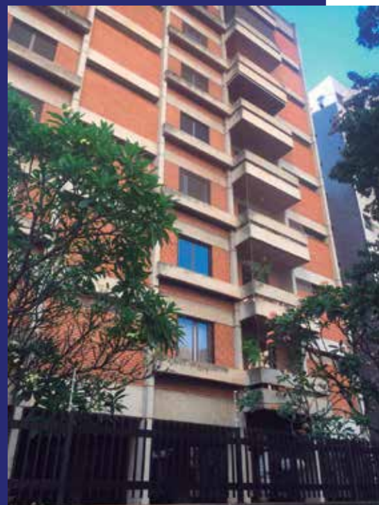
Edifício Zica Junqueira Gallo: 1º de Ribeirão construído com laje protendida
