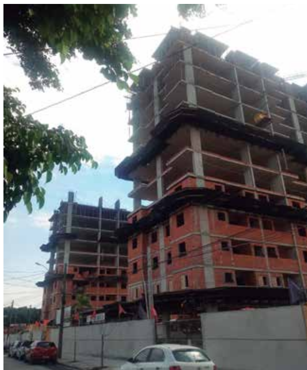
Obra no Guarujá com laje lisa protendida para o Programa Minha Casa Minha Vida
