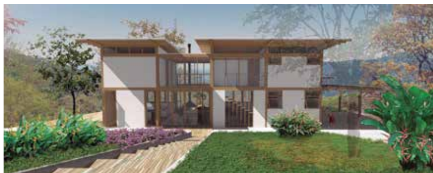
Estrutura de madeira e fechamento com pau a pique revestido de branco
