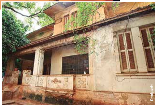
Palacete antes do restauro
