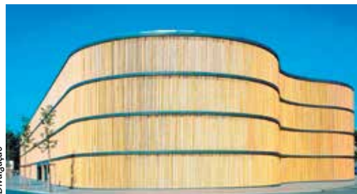
Fechamento de um estacionamento em Leipzig, na Alemanha, feito com varas de bambu. O projeto é dos arquitetos alemães HPP Henrich Petschnigg & Partner KG
