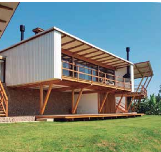
Estrutura de madeira com fechamento de drywall e chapa metálica
