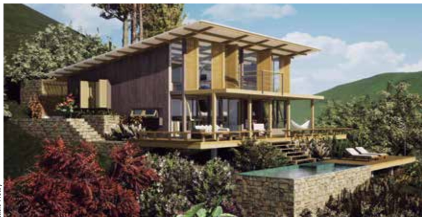
Construção com fechamento misto de alvenaria e isolamento extra com lã de rocha e tábua carbonizada
