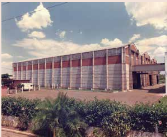
Usina São Geraldo - Sertãozinho - silo de açúcar a granel - Exemplo de paredes de concreto executado com formas trepantes
