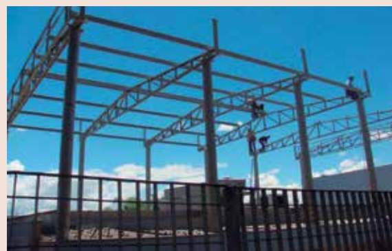
AEAARP - Início içamento de vigas e vista geral da estrutura
