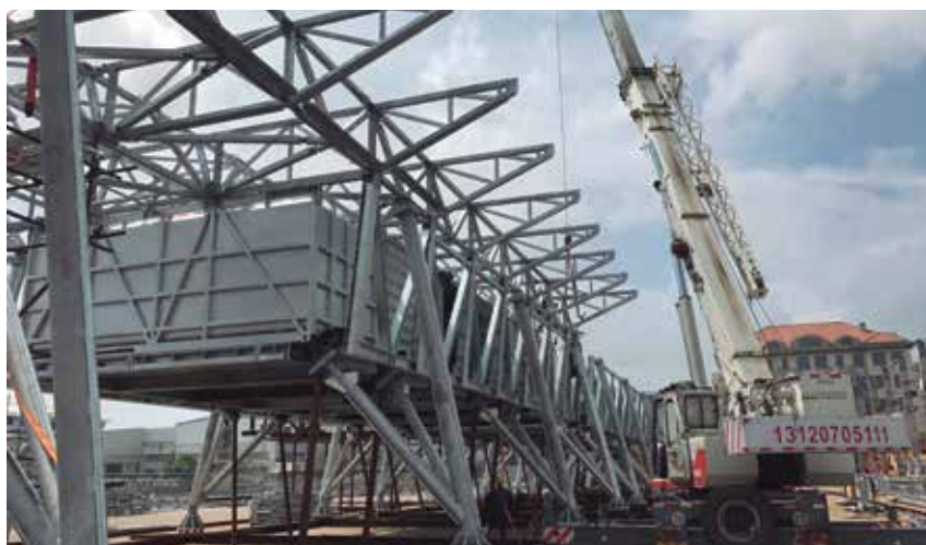
Pré-montagem das estruturas em Xangai, China
