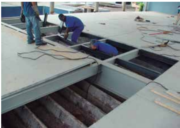
Montagem do piso wall e parede dry wall
