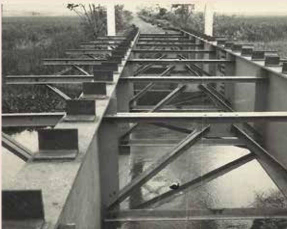
Ponte sobre o rio da Onça, Sertãozinho - exemplo de estrutura metálica pré-fabricada e depois montada na obra
