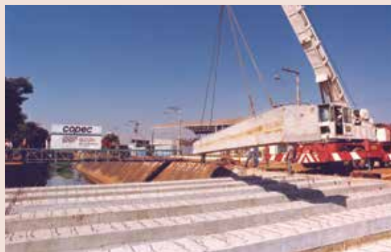
Ponte na Rua Florencio de Abreu x Av. Francisco Junqueira - exemplo de execução com vigas pré-fabricadas e içadas em canteiro
